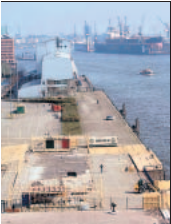
Der Aufbau des Beach-Clubs Hamburg del mar hat begonnen. FOTO: SYLENTPRESS
